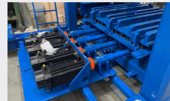
Vibración por servomotor
